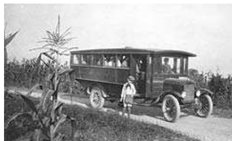
1926 год. Школьный автобус Wayne уже оборудован остекленным кузовом
